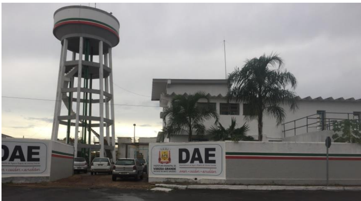
Figura 5 - Estação de tratamento de água- ETA I- Ulisses Pompeo de Campos.
